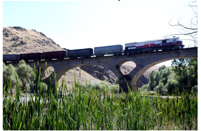
DDY Devrez Köprüsü
