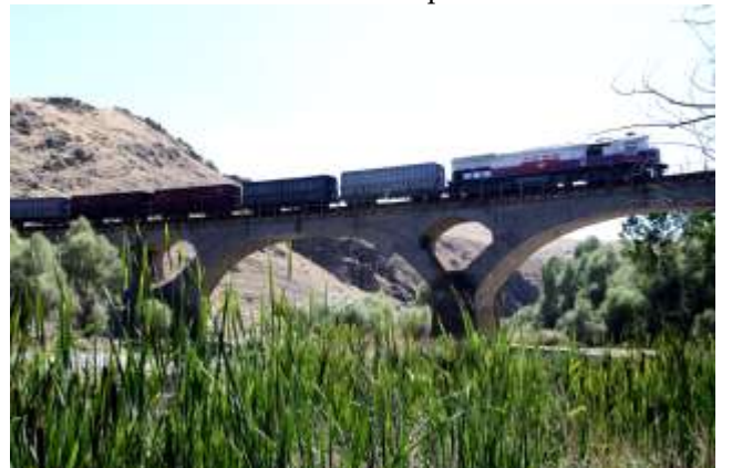
DDY Devrez Köprüsü
